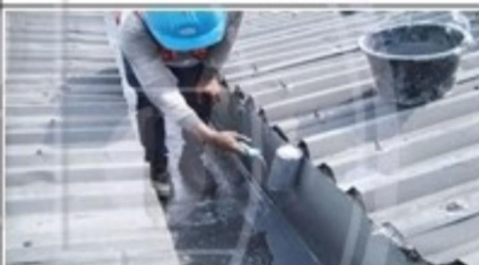
3.2 Pengerjaan Lining/Pelapisan Fiberglass Pada Talang Air Tebal 3mm.
