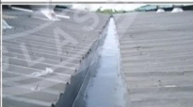
4. Pengerjaan Lining/Pelapisan Fiberglass Talang Air Anti Bocor
