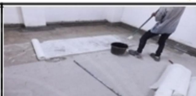
2 Pelapisan chopped strand matt dibasahi dengan polyester resin menjadi pelapisan fiberglass anti bocor
