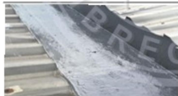
4. Pengerjaan Lining/Pelapisan Fiberglass Talang Air Anti Bocor
