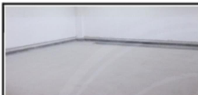
1. Sebelum Pelapisan Fiberglass Lantai Beton
