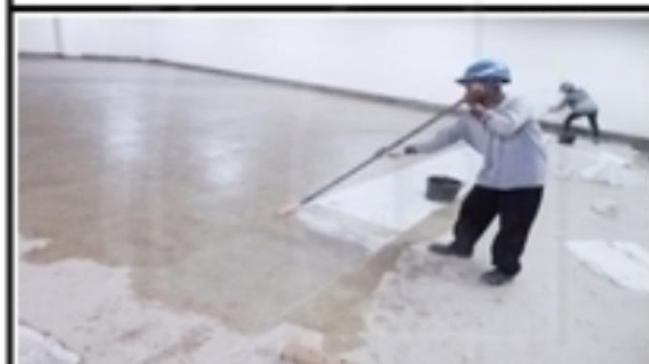
3. Pelapisan fiberglass untuk seluruh lantai beton
